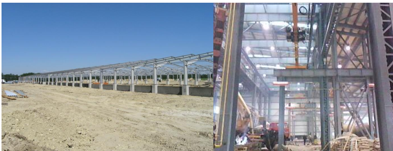
Рис. 1. Объекты строительства ООО «Ирдон»
