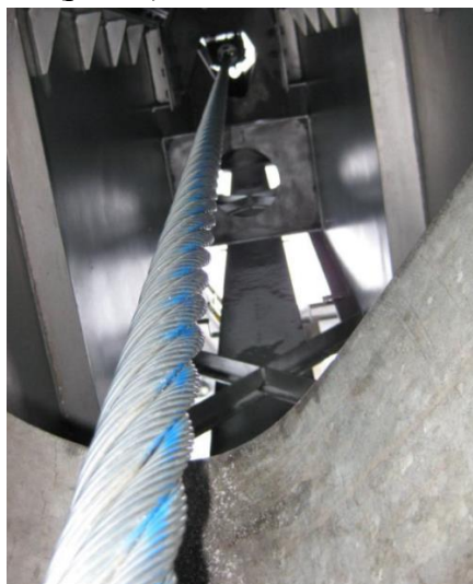
Рис. 5. Линия контроля осевого отклонения (кручения) стального каната вокруг своей оси
