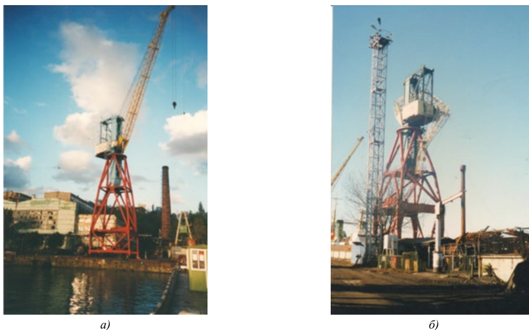
Рис. 3. Авария портального крана по причине разрушения механизма подъема: а — до аварии; б — после аварии
