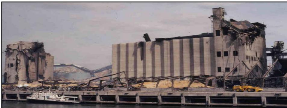
Рис. 1. Взрыв пылевоздушной смеси в силосных корпусах элеватора
