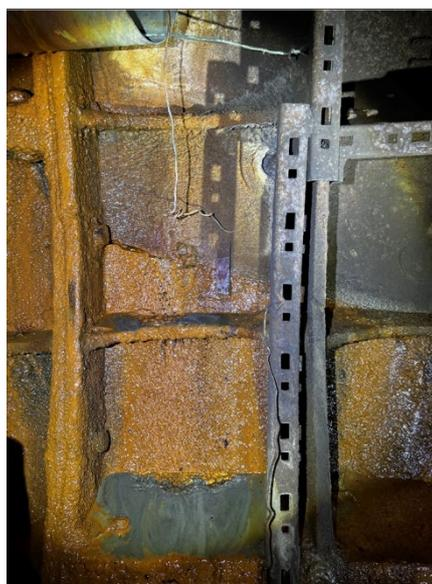
Рис. 4. Выщелачивание и мокрое пятно в межкольцевом и межблочном стыке обделки, активная течь. Трещина в спинке тубинга
