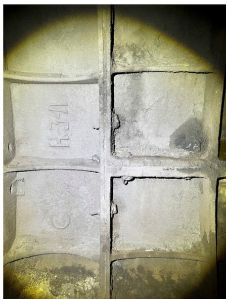
Рис. 3. Неисправность болта
