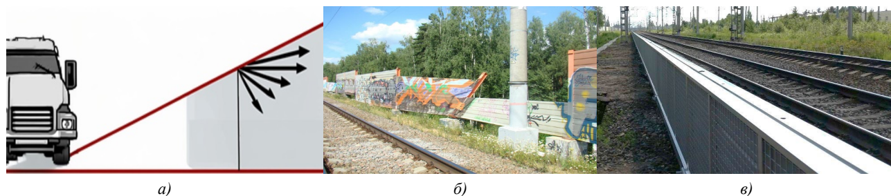
Рис. 1. Применение шумозащитных (акустических) экранов: а — затухание при распространении звука; б — потеря эффективности искусственных шумозащитных конструкций [14]; в — малые акустические экраны [16]
