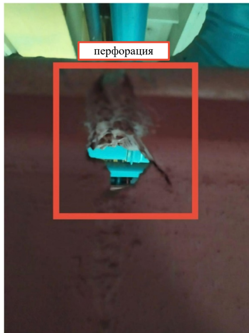
Рис. 6. Перфорация двутавровой балки
